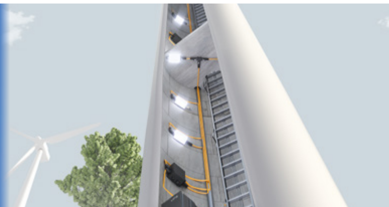
塔台照明和布线
