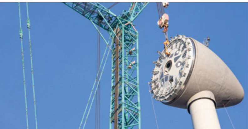
风力发电机吊装
