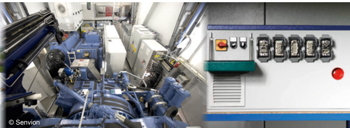
风力发电机机舱内应用：变桨系统 / 控制柜 / 电气开关柜
