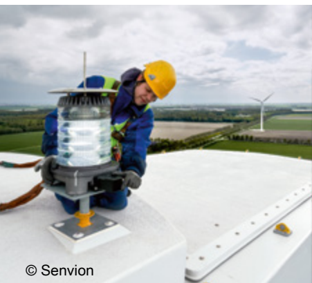
风力发电机机舱外应用： 导航灯 / 测量设备
